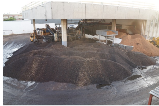
Figura 8 : Sitio de almacenamiento - Agrícola Latianese, extracción de aceite de oliva - Italia
