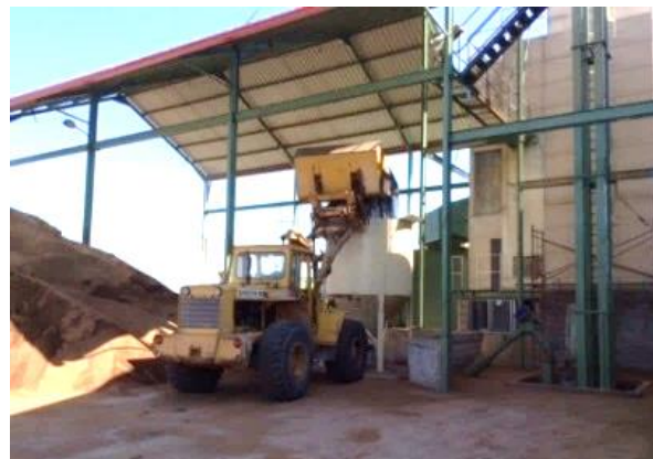
Figure 7 : Installation d'El Cierzo travaillant comme centre logistique de biomasse
